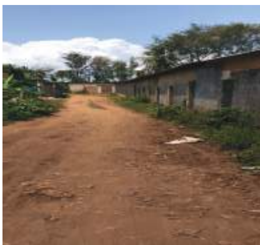
Uwekaji wa fusi njia za ndani shehia ya Fuoni Kibondeni
