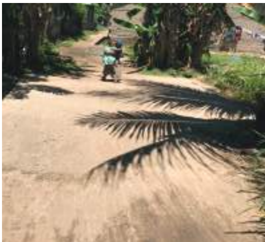
Ujenzi wa kivuko shehia ya Uzi
