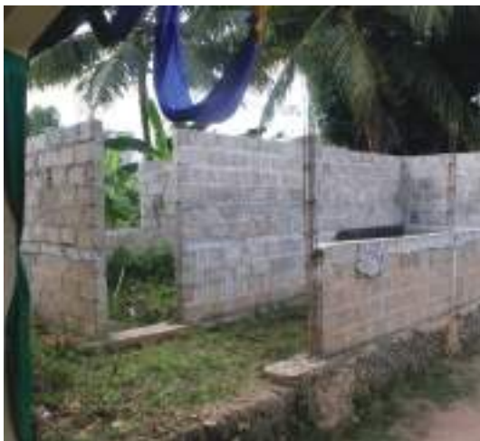
Ujenzi wa maabara ya kituo cha afya Kisauni kwa hatua ya uchimbaji wa msingi hadi linta.
