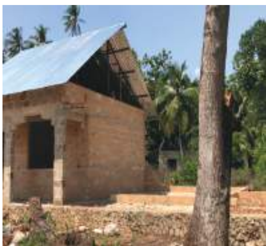
Ujenzi wa msingi wa madrasa shehia ya Uwandani
