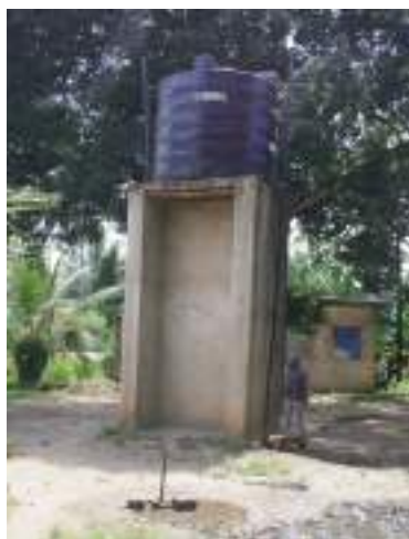
Ununuzi wa tangi la maji lita 5000, mipira ya maji na ujenzi wa mnara wa maji Mwakaje
