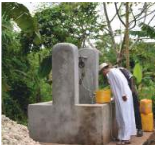
Ujenzi wa kisima cha maji Kitogani
