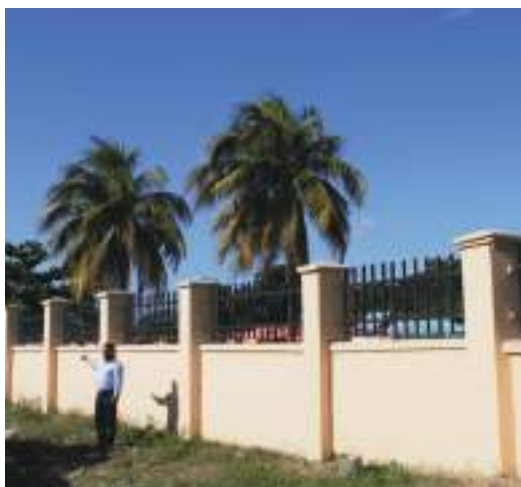
Ujenzi wa ukuta skuli ya msingi ya Muembeshauri
