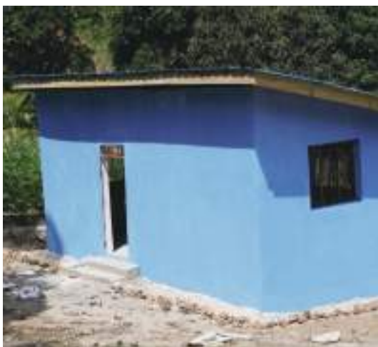
Ujenzi kibanda cha machine ya maji shehia ya Mkokotoni
