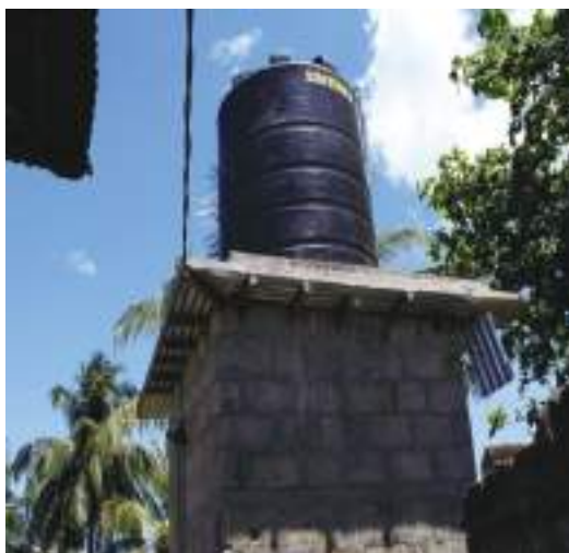
Ununuzi wa tangi la maji na ujengaji wa mnara wa maji shehia ya Masumbani
