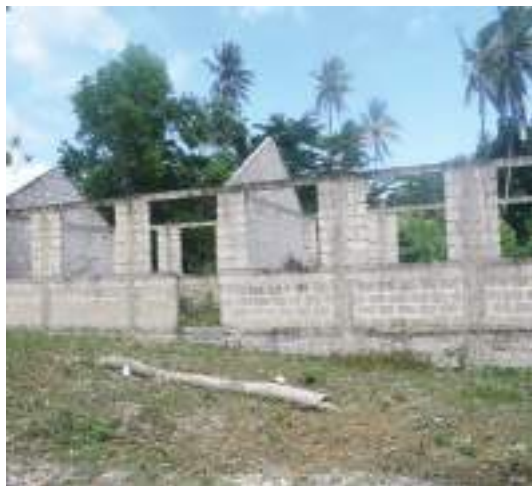
Ujenzi wa madarasa matatu Skuli ya Ukunjwi
