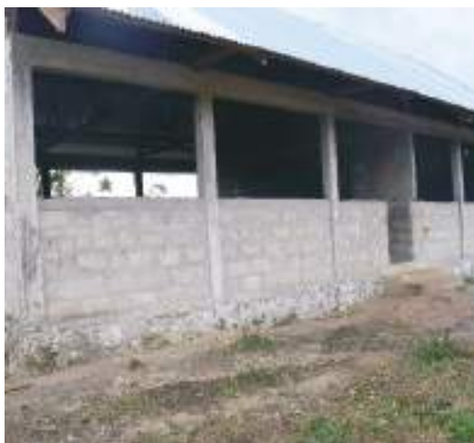
Ujenzi wa madarasa manne Skuli ya Msingi Chimba
