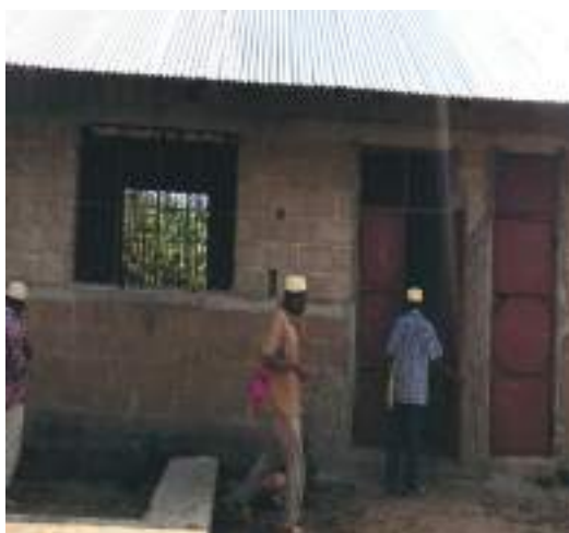
Uendelezaji wa Mradi wa ujenzi wa skuli ya Chekechea Mafufuni
