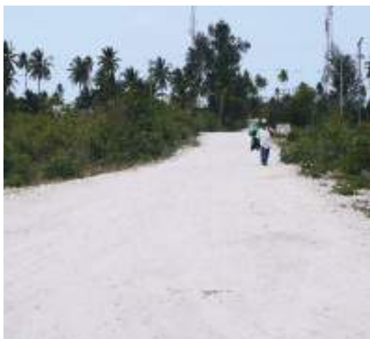
Ujenzi wa barabara kiwango cha kifusi
