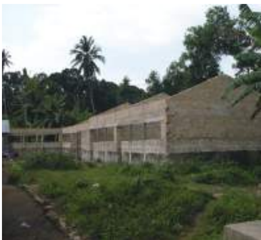
Ujenzi wa madarasa matano, kozi nane na ofisi moja ya Mwalimu Mkuu skuli ya Mwoga
