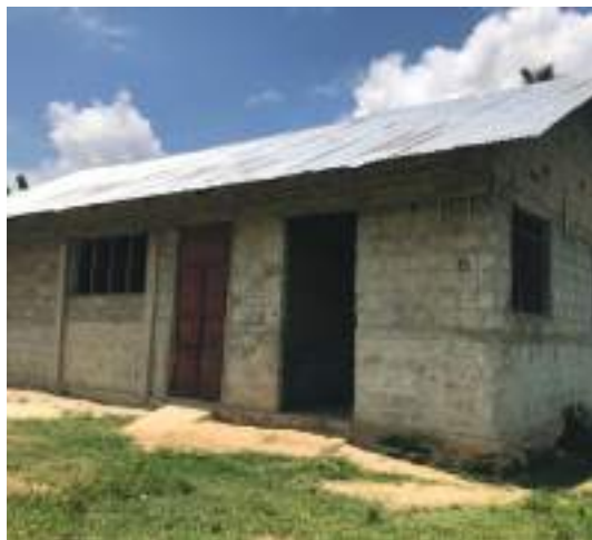
Ujenzi wa TUTU ya mwanakombo shehia ya Mwanakombo
