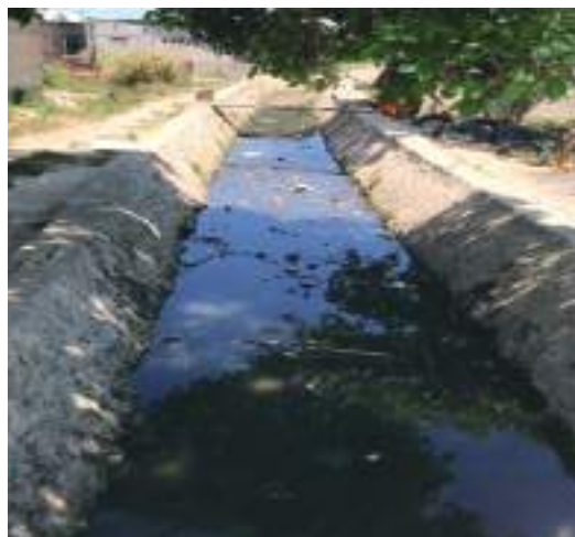
Ujenzi wa mtaro wa maji Mwembe majogoo
