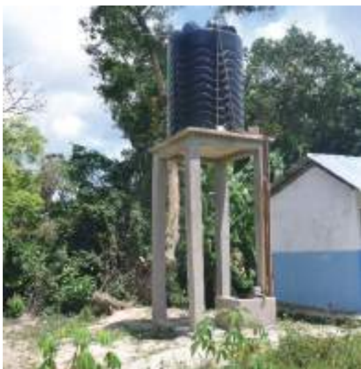
Ujenzi wa mnara pamoja na tanki la maji skuli ya Piki
