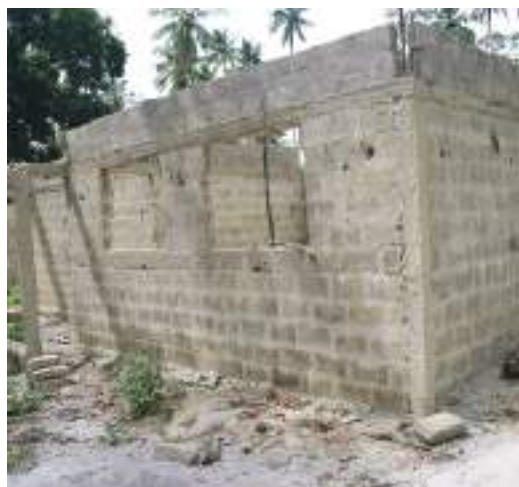
Ujenzi wa Skuli ya Maandalizi Kijichame
