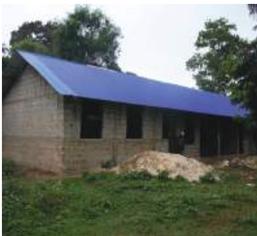
Ujenzi wa darasa moja na Ofisi ya walimu la skuli ya Chekechea ya Mkwajuni
