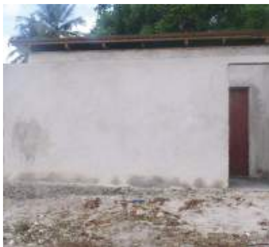
Ujenzi wa vyoo Skuli ya Mkote
