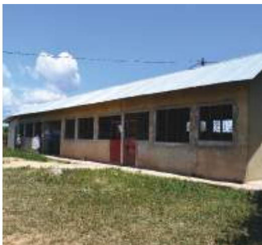
Ujenzi wa Skuli ya chekechea Gube
