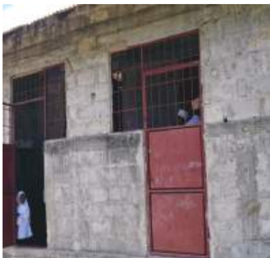
Uwekaji wa milango na madirisha skuli ya Maandalizi Shehia ya Banko
