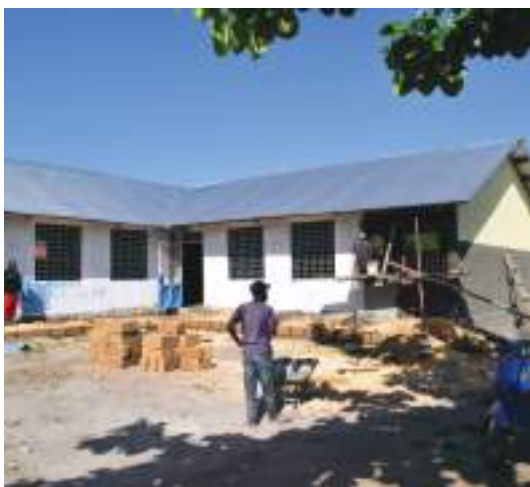
Ujenzi wa mabanda matatu ya skuli ya msingi Chunga
