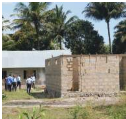
Ujenzi wa vyoo skuli ya chekechea Muwanda
