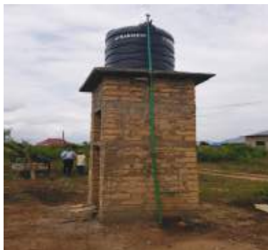
Ujenzi wa mnara wa maji Bungu
