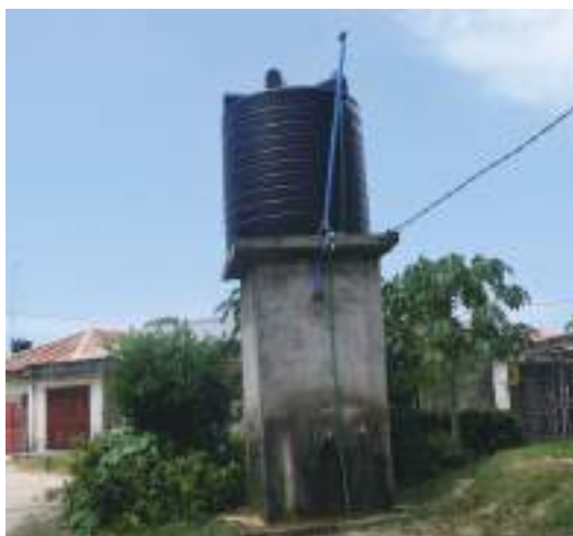
Ujenzi wa mnara wa maji Kiembe Samaki
