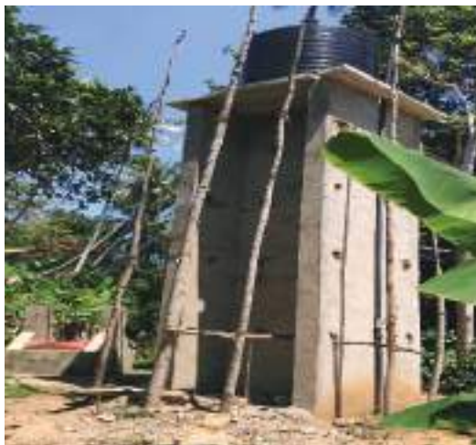
Ujenzi wa mnara na tangi la maji shehia ya Misufini
