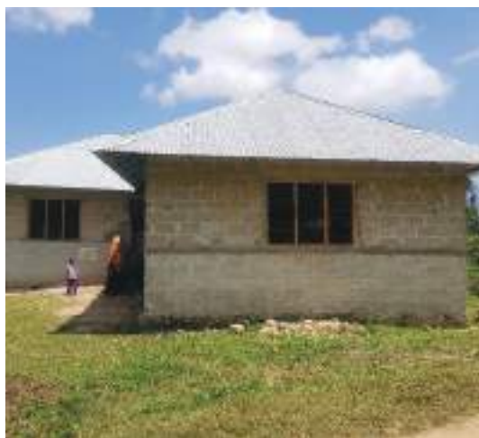
Ujenzi wa skuli ya maandalizi ya TUTU ya Mahonda Mtomchanga
