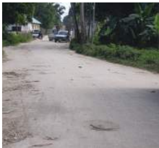
Uwekaji wa kifusi njia za ndani shehia ya Fuoni Migombani
