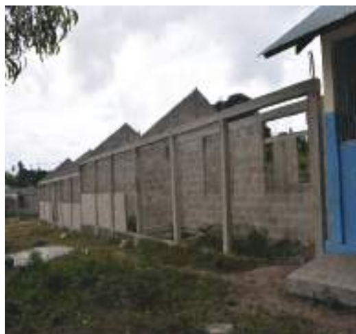
Uendelezaji wa ujenzi wa Skuli Wingwi Simai
