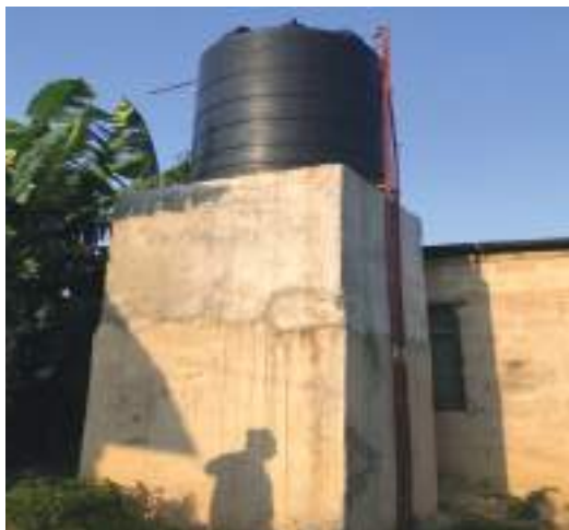
Ujenzi wa mnara wa maji Mtoni
