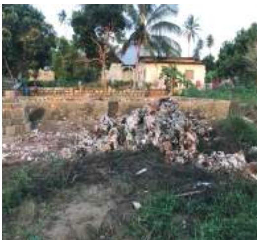
Ujenzi wa Madrasa ya Mtoni
