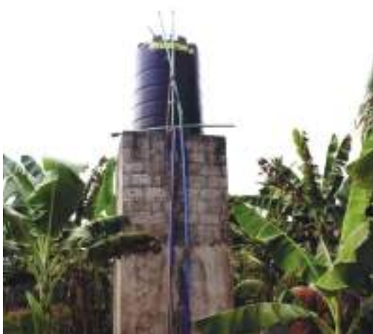
Ununuzi wa tangi, mipira ya maji na ujenzi wamnara wa maji Fuoni Kipungani
