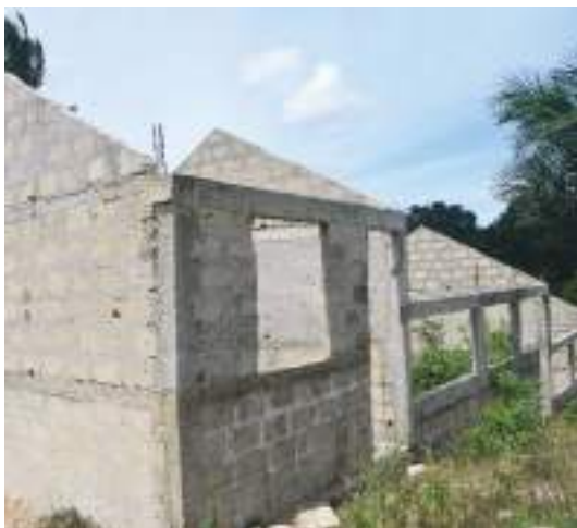
Ujenzi wa skuli ya maandalizi Tungamaa
